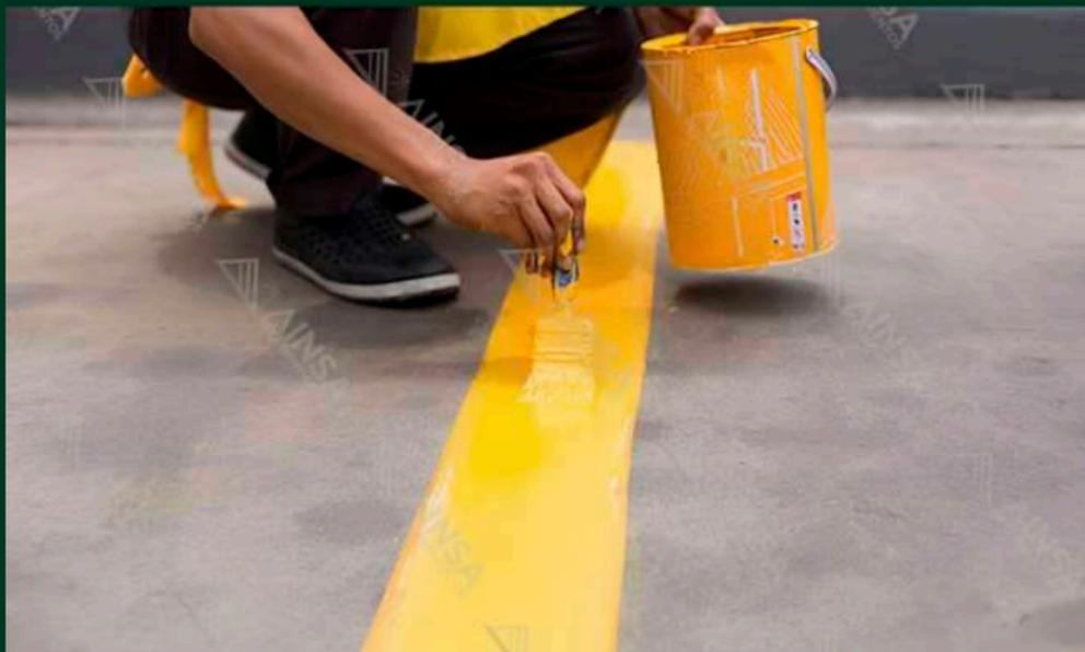
La pintura señalética se puede aplicar con brocha, rodillo o pulverización, y es compatible con diversos materiales, incluidos el concreto, el metal y el asfalto. Su diseño permite crear líneas, flechas, pictogramas y textos que facilitan la comunicación visual en cualquier entorno.
